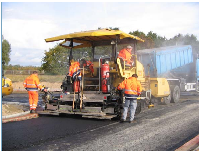
Asphaltierungsarbeiten in der Wilhelm-Karmann-Straße
