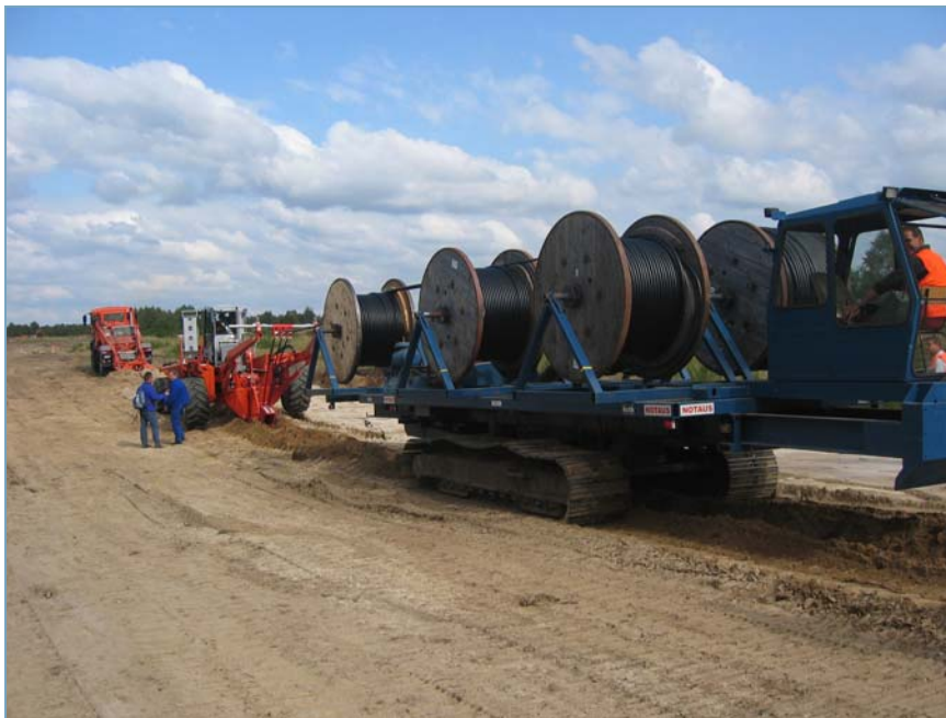
Kabelpflug, gleichzeitiger Einzug von 3 Mittelspannungskabeln
