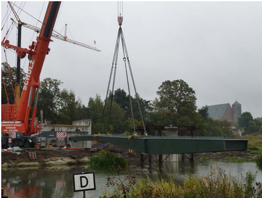
Neubau der Südbrücke in Verden Aller
