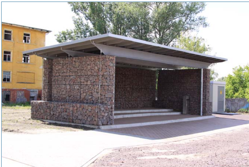
Wetterschutz in Gabionenbauweise
